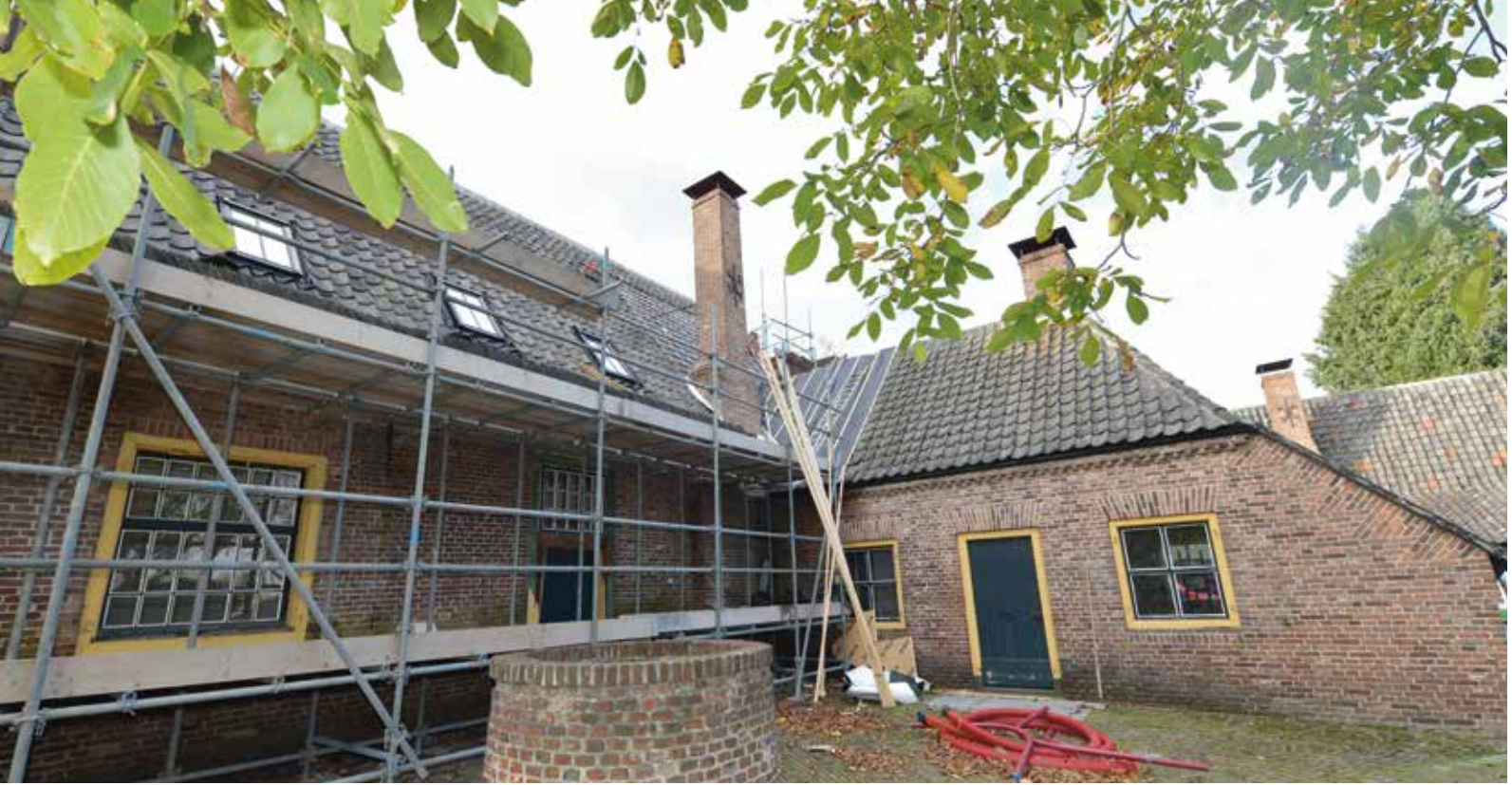
Links de achtergevel in de steiger, rechts de aanbouw uit 1967 in historiserende stijl.
