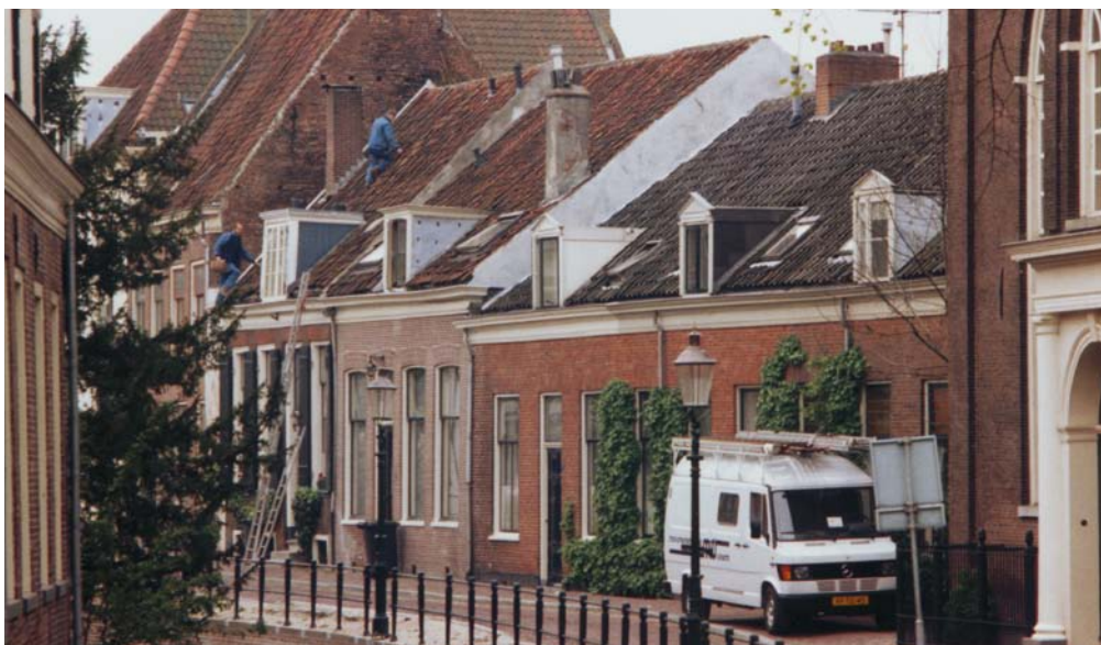
De monumentenwacht inspecteert een woonhuismonument aan de Lange Gracht in Amersfoort
